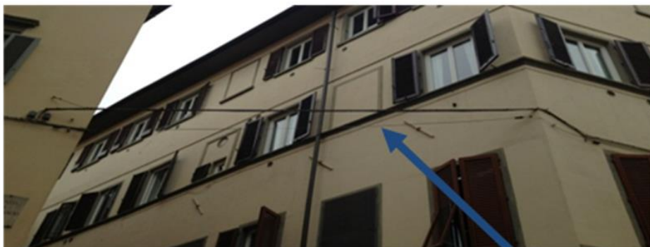
Cavo ottico in attraversamento
